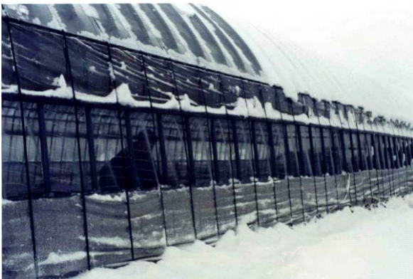
写真2 ハウスのサイドに防風ネットを張り、開放している様子
